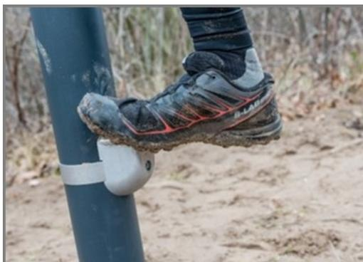
Die Stufen bestehen aus extrudiertem Aluminium mit einer rutschfesten Oberfläche. Aluminium hat eine hohe Korrosionsbeständigkeit und gewährleistet die Haltbarkeit des Produkts. Die Stufen wurden in Höhen von 34,7 cm und 54,7 cm montiert, was einen leichten Zugang zum Erreichen der Überkopftätigkeit ermöglicht.
