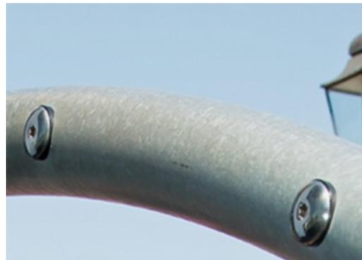
钢拱在内部和外部均用无铅热浸镀锌。镀锌在外部环境中具有出色的耐腐蚀性，并且维护成本低。
