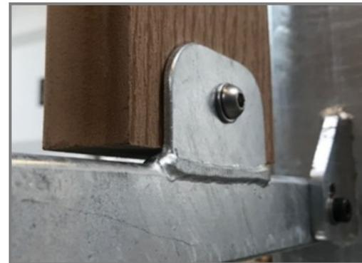
Las placas WPC están unidas a bridas soldadas de 70 x 45 x 3 mm con pernos, tuercas y arandelas de acero inoxidable M8. Estas conexiones no son visibles desde el interior y crean una conexión fuerte y segura.
