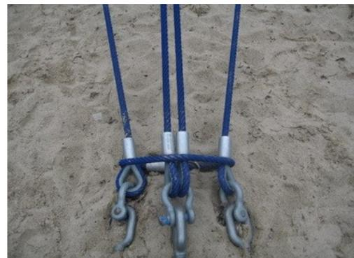
Les filets les plus grands sont fixés aux fondations avec un système de trois tendeurs. Les câbles porteurs horizontaux et verticaux sont fixés à des tendeurs individuels, chacun se connectent ensuite à un ancrage en acier. Ce système assure que chaque câble est tendu séparément et augmente la sécurité structurelle avec des ancrages indépendants.
