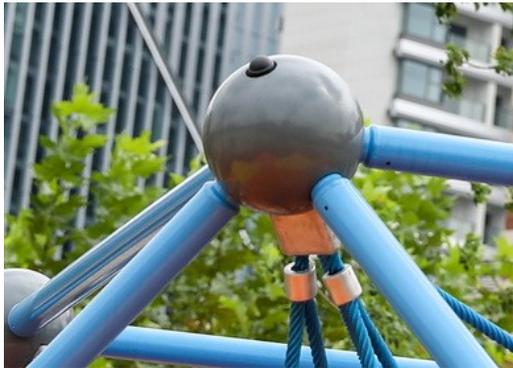
Die Metallteile sind aus hochwertigem Stahl gefertigt, innen und außen mit bleifreiem Zink feuerverzinkt. Auf der Außenseite befindet sich zusätzlich eine Pulverbeschichtung. Dies gewährleistet sowohl eine ausgezeichnete Korrosionsbeständigkeit als auch einen farbenfrohen Designausdruck.
