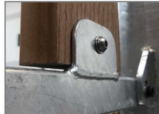
Die Holz-Kunststoff-Verbund-Bretter (WPC) sind durch Edelstahlschrauben (M8 Gewinde), Muttern und Unterlegscheiben mit 70 x 45 x 3 mm großen, geschweißten Flanschen verbunden. Diese Verbindungen sind von innen nicht sichtbar und bilden eine stabile und sichere Verknüpfung.
