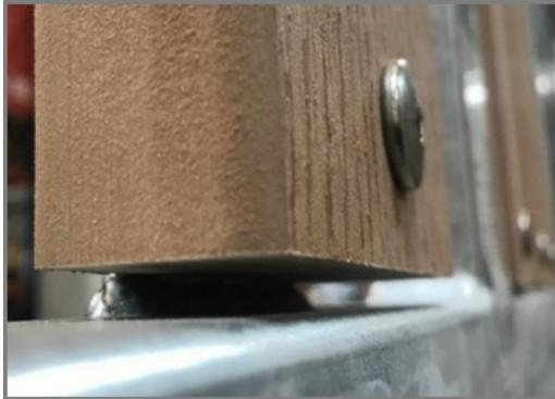
Die Holz-Kunststoff-Verbund-Banden bestehen aus 100 % recyceltem Faser-/Holzpulver und Polyethylen (HDPE). Mit den Abmessungen 860 x 110 x 30 mm sind die Bretter extrem stabil.
