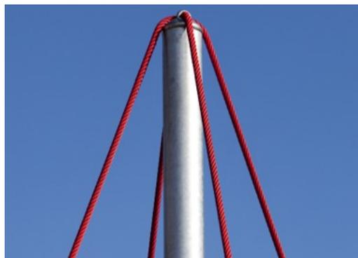
Al centro della rete si trova l'albero, realizzato in acciaio senza saldatura di alta qualità. La struttura dell'albero come supporto oscillante è staticamente favorevole ed equalizza le oscillazioni nella rete. Gli alberi sono zincati a caldo, con l'opzione di progettazione di verniciatura a polvere aggiuntiva.
