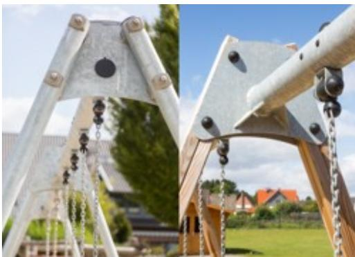
La struttura ad "A" delle altalene è progettata con una traversa ø100mm zincata a caldo con grandi piastre terminali in acciaio per un fissaggio sicuro delle due opzioni di montante: acciaio ø70mm zincato a caldo. Legno di pino impregnato con basi in acciaio zincato a caldo.
