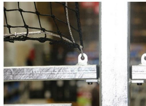
Das Netz besteht aus 4 mm Ø schwarzem Nylon mit einer Maschenweite von 45 x 45 mm und hat eine Höhe von 5 m. Das Netz sorgt dafür, dass alle Bälle innerhalb der Multisportarena bleiben und die Transparenz beibehalten wird.
