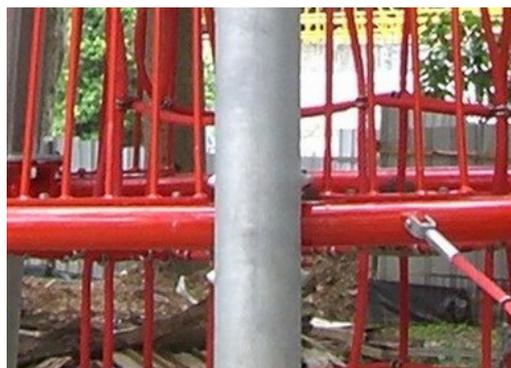
Le parti metalliche sono realizzate in acciaio di alta qualità, zincate a caldo all'interno e all'esterno con zinco senza piombo. All'esterno, c'è un ulteriore strato di verniciatura a polvere. Ciò garantisce sia un'eccellente resistenza alla corrosione sia un'espressione colorata del design.
