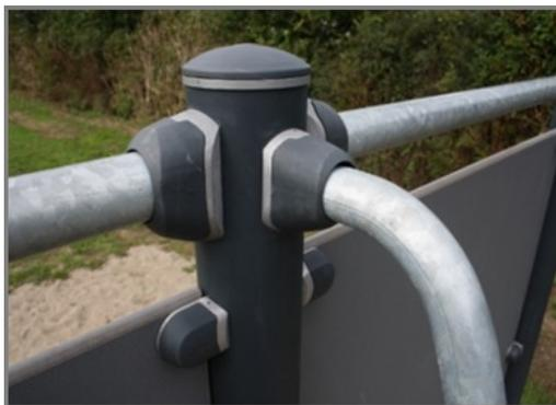
Les connecteurs sont faits d'aluminium moulé, avec un alliage spécialement conçu pour les environnements extérieurs et une utilisation intensive. Les vis fixant les connecteurs sont en acier inoxydable et protégées par des rondelles en zinc.
