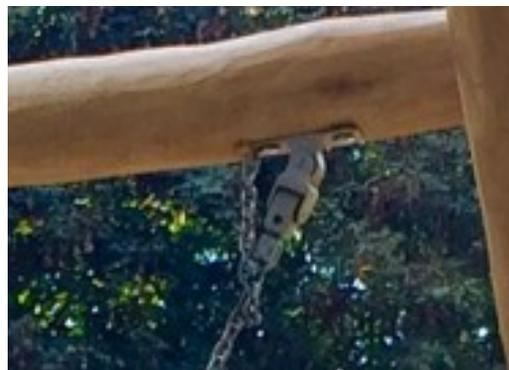
Schaukelaufhängungen für Robinia Querbalken bestehen aus Edelstahlhalterungen und können über zwei Achsen bewegt werden. Das Kunststofflager besteht aus Silikon, wodurch die Aufhängung wartungsfrei ist.
