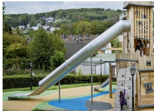
Die gebogenen und geraden Röhrenrutschen aus rostfreiem Stahl werden von mehreren Stahlstangen und einem zentralen Stahlpfosten gestützt. Die Röhrenrutschen sind mit perfekter Krümmung und Neigung für eine rasantes und aufregendes Rutscherlebnis konzipiert.
