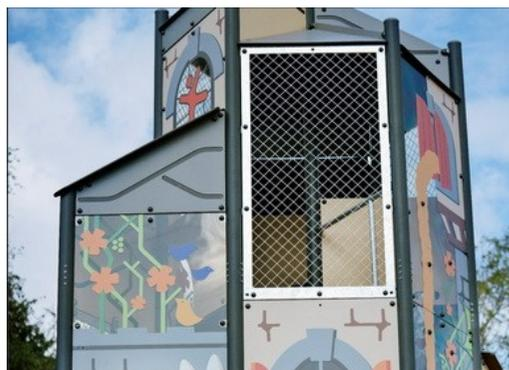
Cadre en acier entièrement soudé, consistant en une grille en fil d'acier Ø4 mm soudée à 45°. Le panneau laissant passer l'air contribue à l'intégrité structurale globale des tours GIANTS.
