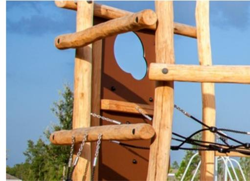
Panneau d'escalade en contreplaqué. Les panneaux d'escalade sont fabriqués en contreplaqué de 21,5 mm d'épaisseur en bois d'aulne et de pin. Les deux côtés sont revêtus de 2 couches de film phénolique avec texture en maillage anti-dérapante. Tous les bords de coupe sont encapsulés avec de la peinture afin d'assurer une longue durée de vie.
