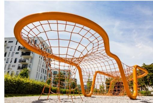
Die Stahloberfläche der geschweißten Stahlrohre ist mit einer Grundschicht und einer Deckschicht aus bleifreiem Farbmateriale nasslackiert. Die Farbe ist äußerst korrosionsbeständig und wartungsfreundlich.
