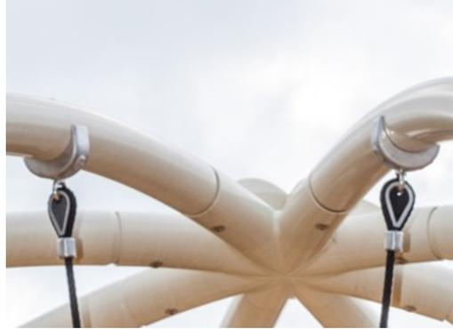
Corocord 铝夹用作钢柱和绳索之间的连接器。铝铸件被拧入钢柱并安全地连接到绳索。
