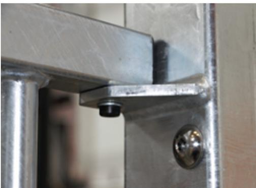
Die Pfosten sind aus 80 x 80 x 3 mm Querschnitten mit horizontal geschweissten 6 mm Flanschen gefertigt. Dies ermöglicht eine einfache Montage und eine stabile Konstruktion. Die Polyethylen Kappen auf den Pfosten sind mit Blindnieten befestigt.
