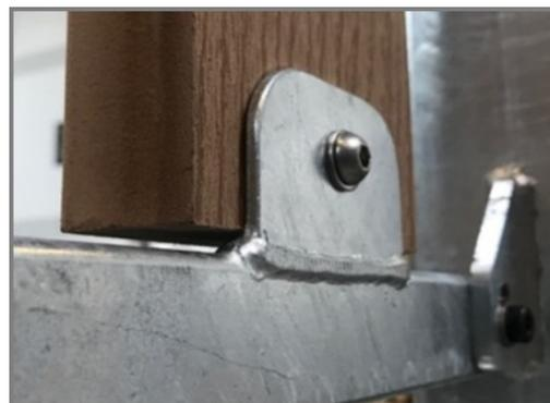
Die Holz-Kunststoff-Verbund-Bretter (WPC) sind durch Edelstahlschrauben (M8 Gewinde), Muttern und Unterlegscheiben mit 70 x 45 x 3 mm grossen, geschweissten Flanschen verbunden. Diese Verbindungen sind von innen nicht sichtbar und bilden eine stabile und sichere Verknüpfung.
