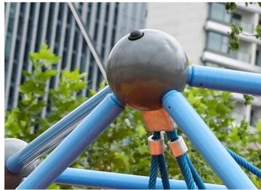
Die Metallteile sind aus hochwertigem Stahl gefertigt, innen und außen mit bleifreiem Zink feuerverzinkt. Auf der Außenseite befindet sich zusätzlich eine Pulverbeschichtung. Dies gewährleistet sowohl eine ausgezeichnete Korrosionsbeständigkeit als auch einen farbenfrohen Designausdruck.
