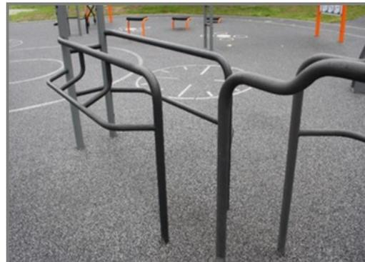
Das Produkt bietet zwei Sätze paralleler Stäbe  $\varnothing 48,3 \times 4$  mm, drei verschiedene Höhen (104, 114 und 124 cm) und vier untere Seitenstäbe  $\varnothing 33,7 \times 3$  mm. Kombiniert bieten diese 6 Stangen eine Vielzahl von Trainingsmöglichkeiten.
