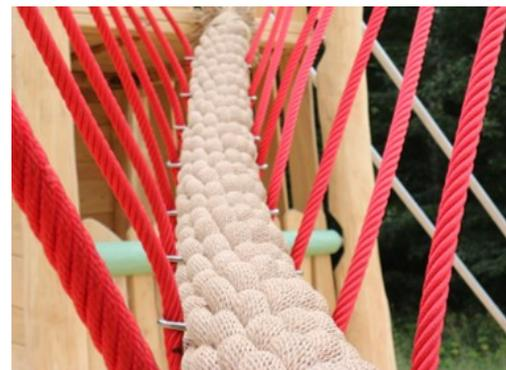
Les cordes Corocord du pont sont spéciales de type « Hercules » avec des torons d'acier galvanisés à six brins et un coeur en câble d'acier. La Corde PP "Coco" a un diamètre de 15 cm. Le coeur en acier du câble est muni de cosses aux deux extrémités, qui servent à fixer le câble aux éléments de connexion existants.
