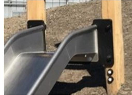
Anschlusselement an der Rutsche aus 19 mm EcoCore™. EcoCore™ ist ein äusserst langlebiges, umweltfreundliches Material. Nach Gebrauch ist es recycelbar und es besteht aus +95 % recyceltem Post-Consumer-Material z. B. aus Lebensmittelverpackungen - sowohl im Kern als auch in der bunten Aussenschicht.
