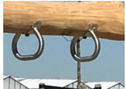
Die Klettergriffe sind aus Edelstahl gefertigt. Die Griffe werden mit Verbindungselementen aus Edelstahl an den oberen Robinia Querträger angebracht.
