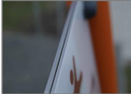
大型指示牌是一块夹心的结构，它在 2 x 6mm 的聚碳酸酯板中内嵌印刷清晰的指示内容。这是一个防破坏的结构。
