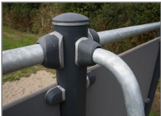
Les connecteurs sont faits d'aluminium moulé, avec un alliage spécialement conçu pour les environnements extérieurs et une utilisation intensive. Les vis fixant les connecteurs sont en acier inoxydable et protégées par des rondelles en zinc.
