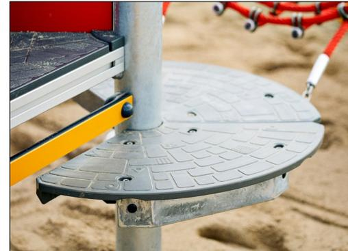
Die grauen runden Pfostenplattformen werden von feuerverzinktem Stahl gestützt und bestehen aus geformtem 75%igem PP-Material mit rutschfestem Muster und strukturierter Oberfläche.
