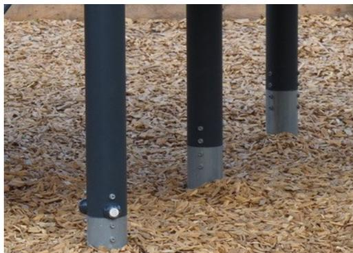
I pali principali con basamento in acciaio zincato a caldo sono disponibili in diversi materiali: Pali in legno di pino impregnato a pressione. Pre-zincato all'interno e all'esterno con montanti in acciaio verniciato a polvere. Alluminio senza piombo con finitura superiore anodizzata a colori.
