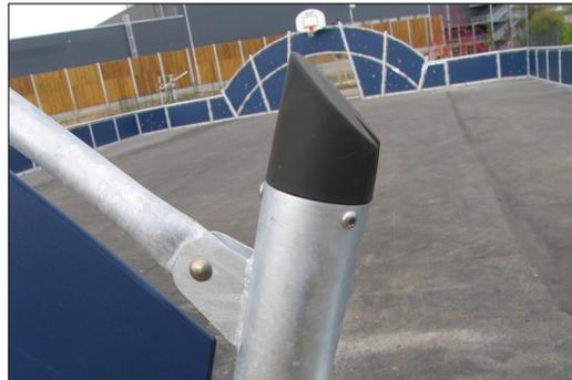
Die Pfostenoberteile sind aus thermoplastischem Gummi (TPV) mit einer Stahleinlage geformt. TPV ist sehr widerstandsfähig gegen Abnutzung und Verschleiß, und die Stahleinlage sorgt für eine hohe Dauerhaftigkeit.
