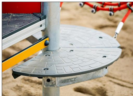
Toutes les plateformes sont soutenues par une unique structure en acier, possédant des supports et fixations multiples. D'une épaisseur de 17,8 mm, les plateformes HPL offrent une très grande résistance à l'usure et sont équipées d'une texture de surface antidérapante propre à KOMPAN.
