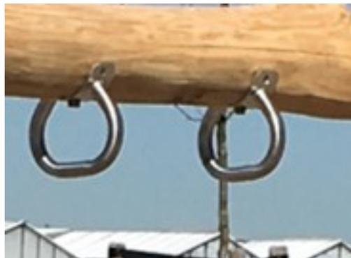
Les poignées d'escalade sont fabriquées en acier inoxydable de haute qualité. Les poignées sont fixées à la poutre transversale supérieure Robinia par de la visserie en acier inoxydable.
