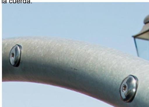
Los arcos de acero están galvanizados en caliente por dentro y por fuera con zinc sin plomo. La galvanización tiene una excelente resistencia a la corrosión en ambientes exteriores y requiere poco mantenimiento.
