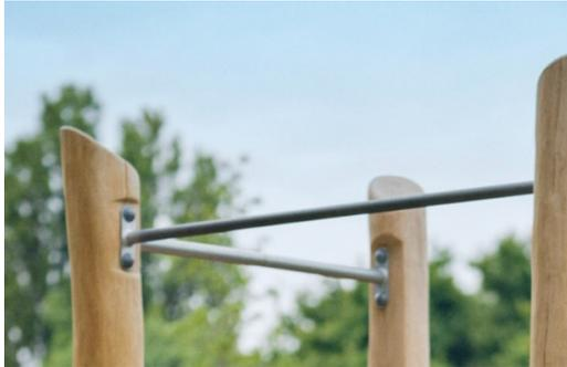
Alle Stangen, die für Klimmzüge vorgesehen sind, bestehen aus massiven, feuerverzinkten Stahlstangen (S235JR) mit einem Durchmesser von 32 mm x 138 mm. Dieser Durchmesser bietet für jeden den richtigen Halt.
