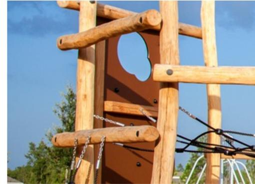
Holz-Kletterwand. Die Kletterwände bestehen aus 21,5 mm dicken Siebträger Platten aus Erlen- und Kiefernholz. Beide Seiten sind mit 2 Lagen Phenolfilm mit Antirutsch-Beschichtung bedeckt. Alle Schnittkanten sind mit Farbe versiegelt, um eine lange Lebensdauer zu gewährleisten.
