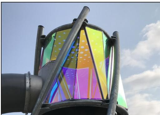
I pannelli grafici sono realizzati in policarbonato di alta qualità con uno spessore di 6 mm. La pellicola dicroica che cambia colore è incollata all'esterno. I pannelli in PC sono stabilizzati ai raggi UV per prevenirne il degrado.
