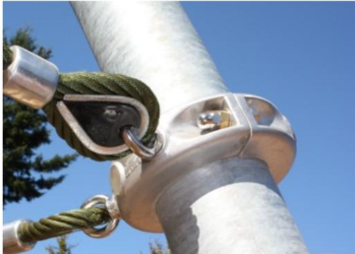
Die Corocord-Aluminiumschellen werden als Verbindungselemente zwischen Stahlpfosten und Seil verwendet. Zwei Formteile aus Aluminium werden hierbei miteinander verschraubt. Dadurch ist die Lage der Schellen in der Höhe verstellbar.
