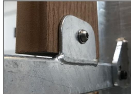
Las placas WPC están unidas a bridas soldadas de 70 x 45 x 3 mm con pernos, tuercas y arandelas de acero inoxidable M8. Estas conexiones no son visibles desde el interior y crean una conexión fuerte y segura.
