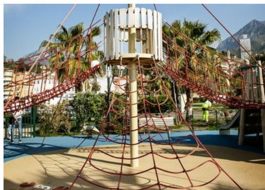
Corocord 16mm 绳索是特殊的“大力神”型绳索，具有镀锌四股钢丝和钢丝芯。每根钢丝束都用 PES 纱紧密包裹，然后将其熔化到每根单独的钢丝束上。这些绳索具有很高的耐磨性和防破坏性，可以根据需要在现场更换。
