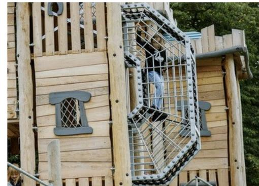
El túnel de estructura de alambre está hecho de acero de alta calidad galvanizado en caliente. Las cuerdas Corocord de 16 mm son especiales del tipo "Hércules" con alambres de acero galvanizado de cuatro hilos y un núcleo de alambre de acero. Cada hebra está bien envuelta con hilo PES, que se funde en cada hebra individual.
