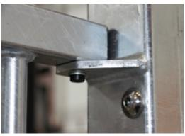
所有的钢构件都是由碳钢焊接而成,符合 EN ISO 5817,热浸镀锌符合 ISO1461。这个工艺确保结构在任何情况下都能得到良好的保护。
