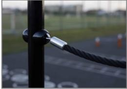
Die Seile bestehen aus UV-stabilisiertem PES mit innerer Stahlseilverstärkung. Das Seil besteht aus +95 % Post-Consumer-Material und ist induktiv auf jede Litze aufgeschmolzen, was zu einer guten Abriebfestigkeit führt.
