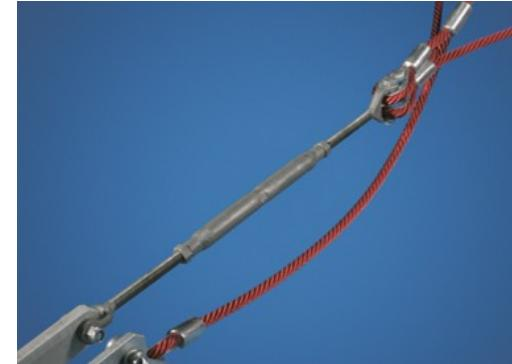
Hlavní nosná lana prostorových sítí jsou vybavena dalším bezpečnostním prvkem: v případě selhání hlavních spojů zabrání bezpečnostní lano zhroucení konstrukce.
