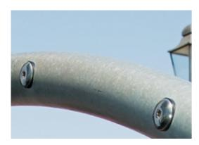
Die Stahlstruktur ist vollständig feuerverzinkt und bleifrei. Die Verzinkung sorgt für eine ausgezeichnete Korrosionsbeständigkeit in allen Aussenumgebungen und macht diese wartungsarm.
