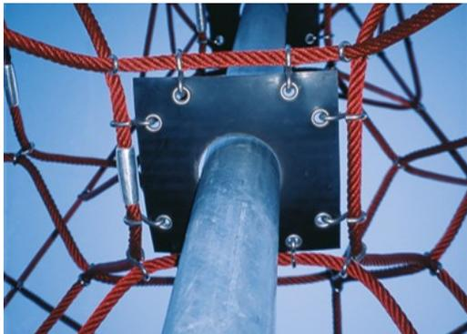
Die Corocord Membranen bestehen aus rutschfestem, gummiertem Material in Förderband-Qualität, das eine exzellente UV-Beständigkeit aufweist. Die geprüfte Konformität mit den REACH-Anforderungen für PAK ist gegeben. In die Membranen ist eine vierlagige Armierung aus gewebtem Polyester eingebettet. Die Armierung und die doppelte
