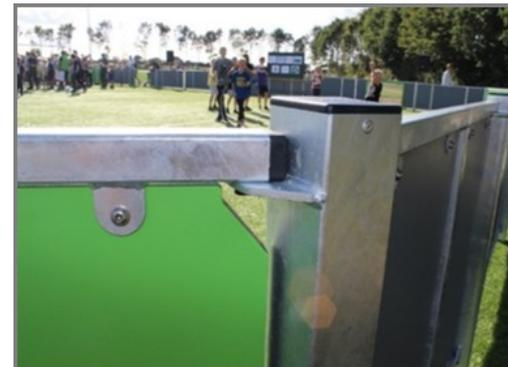
Die Polyethylen-Banden (HDPE) sind durch Edelstahlschrauben (M8 Gewinde) mit 42.5 x 40 x 3 mm großen, geschweißten Flanschen verbunden. Diese Verbindungen sind von innen nicht sichtbar und bilden eine stabile und sichere Verknüpfung.
