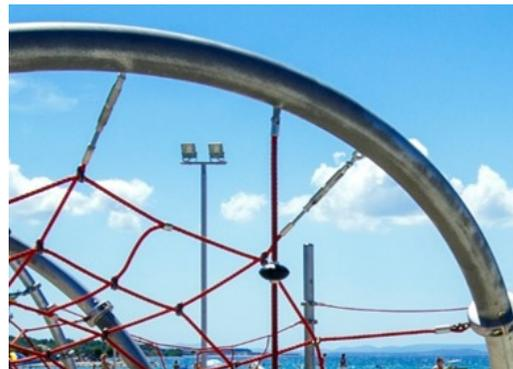
Die Stahlbögen sind vollständig feuerverzinkt und bleifrei. Die Verzinkung sorgt für eine ausgezeichnete Korrosionsbeständigkeit in allen Aussenumgebungen und macht diese wartungsarm.
