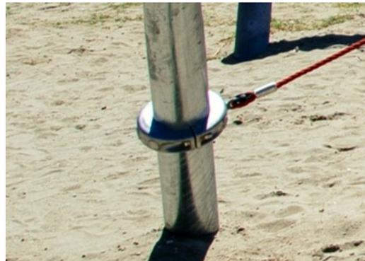
Die Corocord-Aluminiumschellen werden als Verbindungselemente zwischen Stahlposten und Seil verwendet. Zwei Formteile aus Aluminium werden hierbei miteinander verschraubt. Dadurch ist die Lage der Schellen in der Höhe verstellbar.
