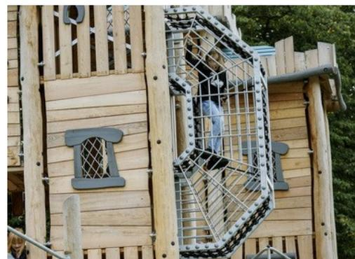
Il tunnel a telaio metallico è realizzato in acciaio zincato a caldo di alta qualità. Le corde Corocord da 16 mm sono di tipo speciale "Hercules" con fili di acciaio zincato a quattro trefoli e un'anima in filo di acciaio. Ogni filo è avvolto strettamente con filo PES, che viene fuso su ogni singolo filo.
