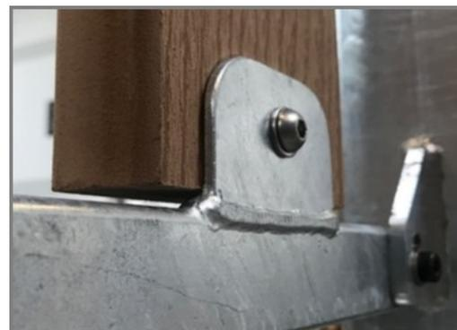
Le schede WPC sono fissate a flange saldate 70 x 45 x 3 mm con bulloni, dadi e rondelle M8 in acciaio inossidabile. Queste connessioni non sono visibili dall'interno e creano una connessione forte e sicura.
