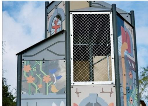
Vollständig geschweisster Stahlrahmen mit 45° kreuzgeschweisstem Stahlgitter mit runden Stahlstiften mit einem Durchmesser von 4 mm. Der Luftstrom-Einsatz trägt zur allgemeinen strukturellen Integrität der GIANT-Türme bei.
