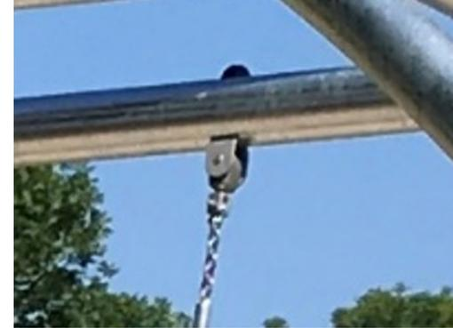
Speziell entwickelte Schaukelaufhängungen aus Edelstahl mit Anti-Überschlag-Funktion. Die Aufhängungen werden mit einem Bolzen am Querbalken montiert, um eine hohe Beständigkeit zu gewährleisten. Das Kunststofflager besteht aus Silikon, wodurch die Aufhängung wartungsfrei ist.
