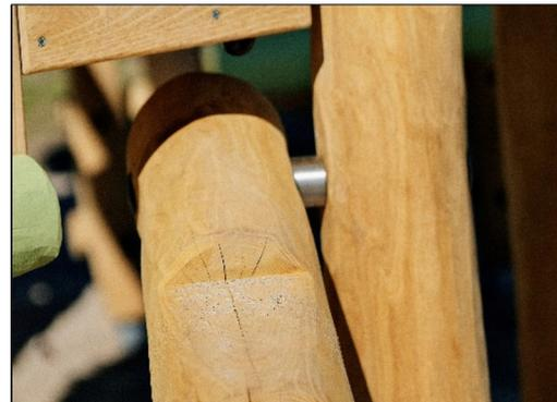
Die Verbindungselemente werden aus Edelstahl oder verzinktem Stahl gefertigt, um für eine hohe Korrosionsbeständigkeit zu sorgen.
